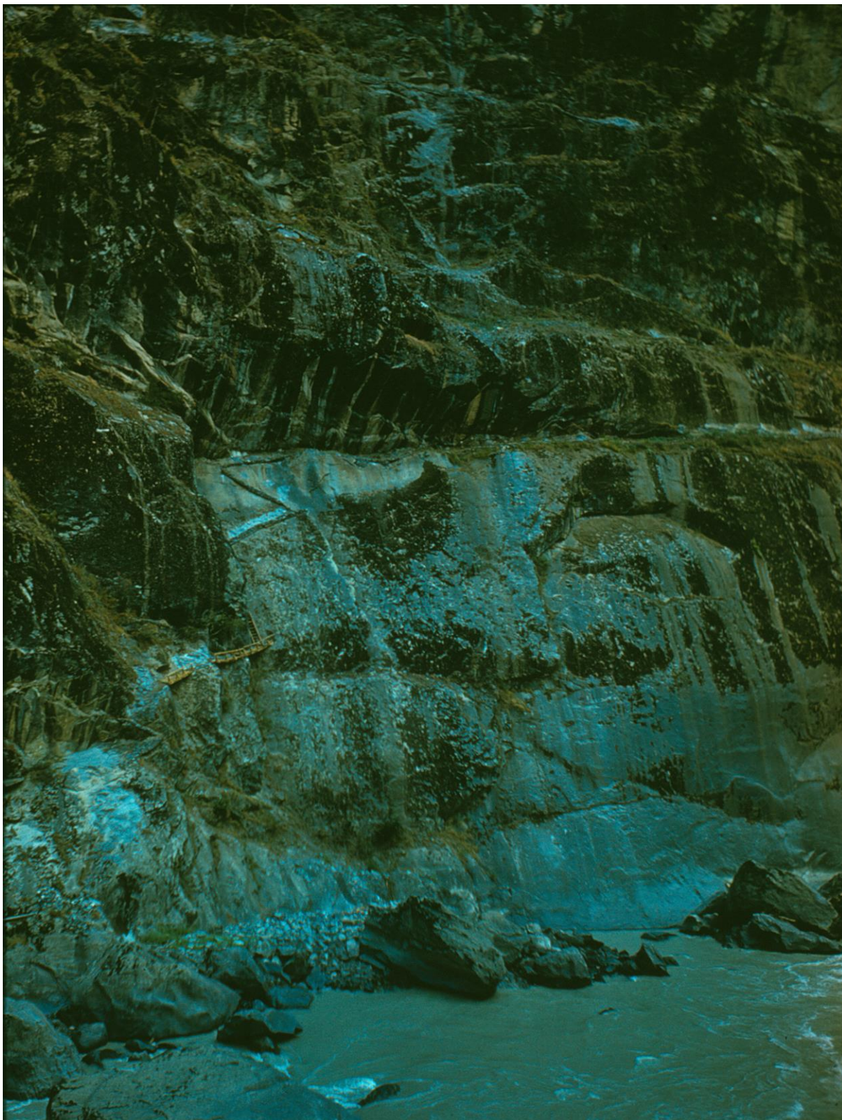
Najkrótsza droga ze wsi Lai do doliny Sung Lai w Kaszmirze. Od lewej prowadzi seria galeryjek w bardzo stromej skale, a dalej w prawo trawers mniej więcej w połowie zdjęcia. Ten trawers to luźne kamienie ułożone na wetkniętych w skalę żerdziach. Szerokość tej „drogi” to miejscami zaledwie ok. 50 cm. Gruby nie przejdzie. Fot. Krzysztof Łoziński.
