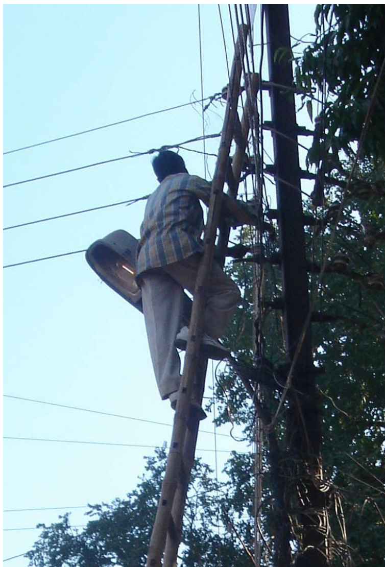
Elektryk, pracując pod prądem, wykonuje nowe podłączenie, Varanasi. Fot. Agnieszka Glinkowska (Łozińska)
